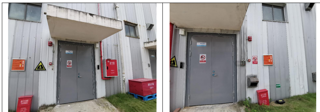
图 4.4-1 危险废物暂存间照片
