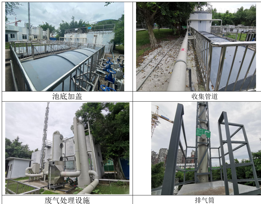
图 4.2-3 恶臭废气处理设施及排气筒照片
