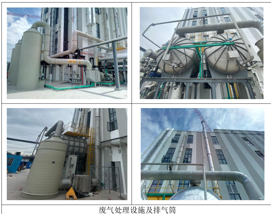
图 4.2-1 中试车间工艺有机废气处理设施及排气筒照片
