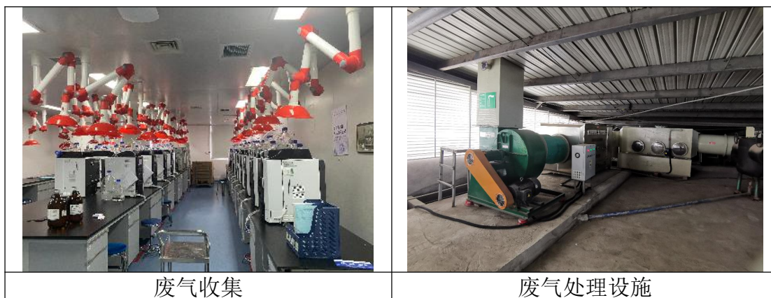
图 4.2-4 质检楼废气处理设施及排气筒照片
